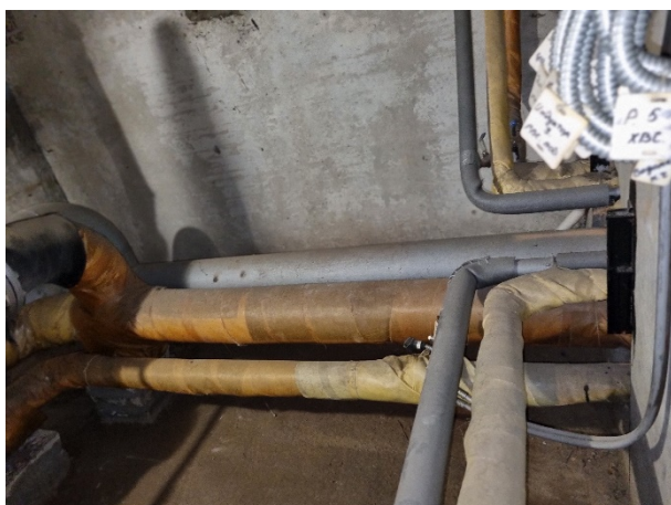
Рисунок 21 (на обратном трубопроводе системы отопления отсутствует изоляция.)
