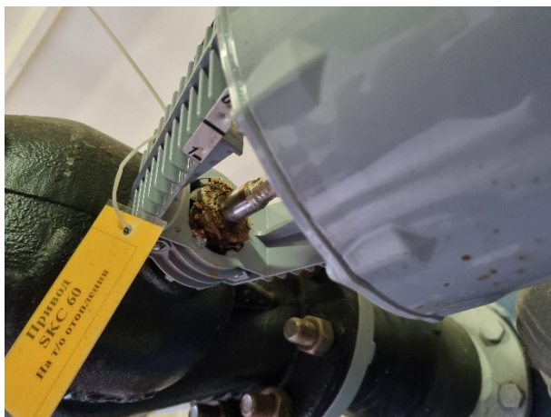
Рисунок 13 (образование известковых отложений в области фиксирующей гайки запорно-регулирующего клапана)
