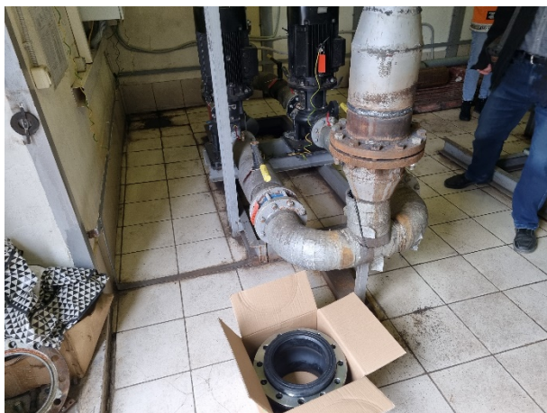
Рисунок 15 (не установлен виброкомпенсатор насосного оборудования системы отопления)
