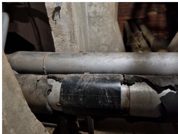
Рисунок 20 (на обратном трубопроводе системы отопления отсутствует изоляция, на подающем трубопроводе системы отопления изоляция повреждена.)
