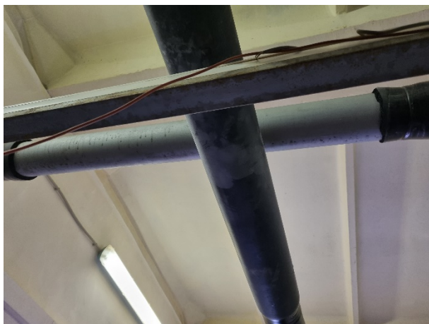
Рисунок 17 (частичное отсутствие изоляции)
