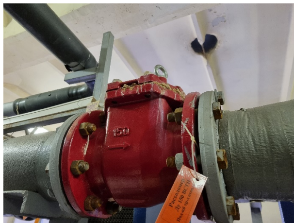
Рисунок 16 (образование известковых отложений на поверхности расходомера)
