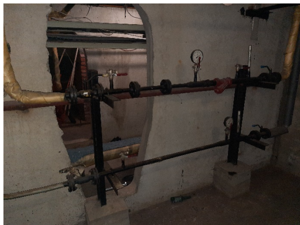
Рисунок 22 (трёхходовые краны, предназначенные для установки манометров перекрыты так как манометры в них отсутствуют.)
