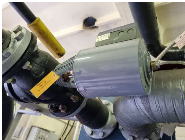
Рисунок 14 (не установлена ручка ручного регулирования электрогидравлического привода)
