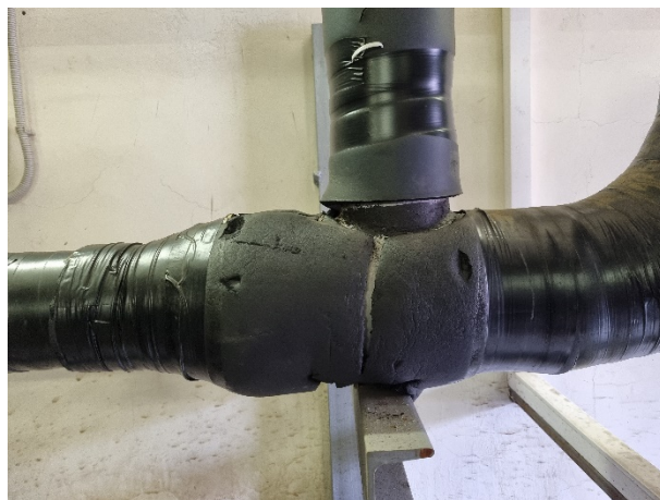
Рисунок 18 (повреждения целостности изоляции)
